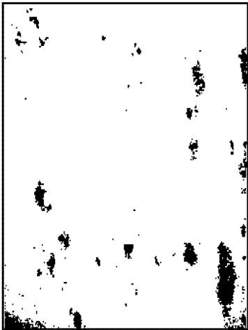
Рисунок А.20 — Коррозия металла — балл К3
