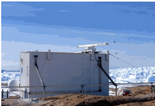
Рисунок 9.16 – Антарктическая станции Прогресс. Панорамная РЛС BRIDGE MASTER E, установленная на холме высотой 61 м для наблюдений за морским льдом и айсбергами в радиусе 30 км, а также динамикой фронта близлежащего выводного ледника Долк (Фото В.Е.Кораблева)
