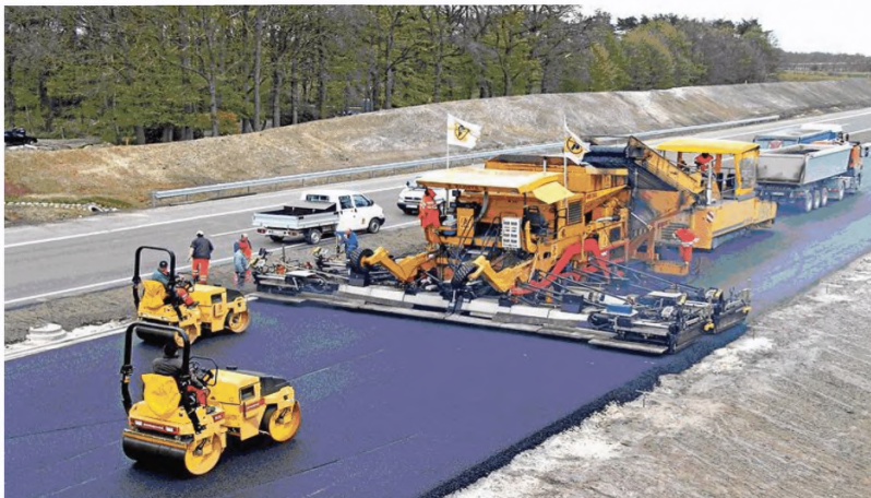
Рисунок 7 – Укладка асфальтобетонной смеси на всю ширину проезжей части
