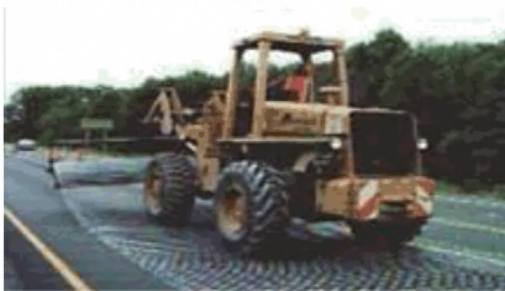
Рисунок 10.1 - Укладка стальной сетки
