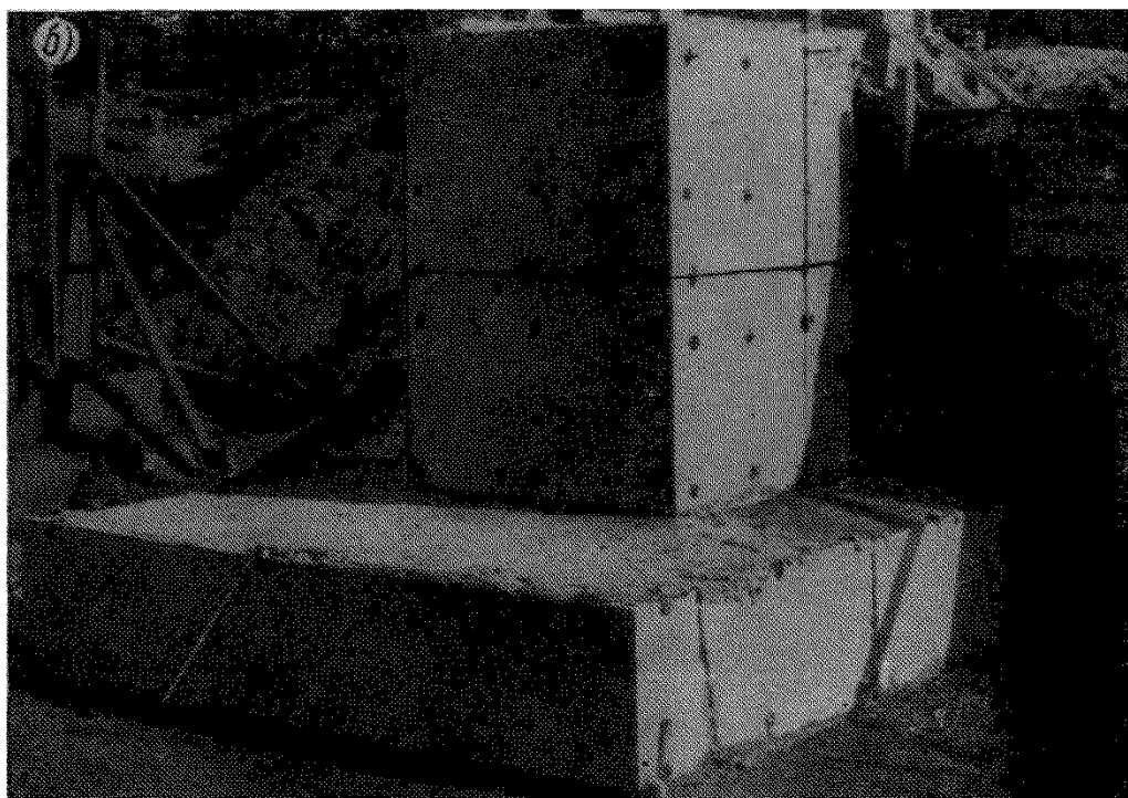
Рис. 11. Несъемная стеклоцементная опалубка фундамента под каркас промышленного здания а — до бетонирования; б — после укладки бетона
