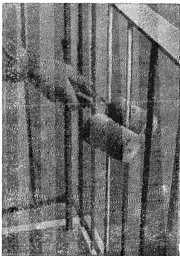
Рис. 14. Окраска балконных ограждений двойным поролоновым валиком
