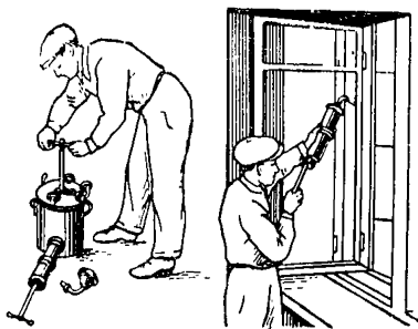
Рис. 31. Заправка шприца замазкой (слева) и промазка им фальцев устатовленного переплета (справа)
