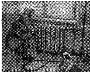
Рис. 13. Окраска радиаторов пистолетом-распылителем СО-19А (С-512А)
