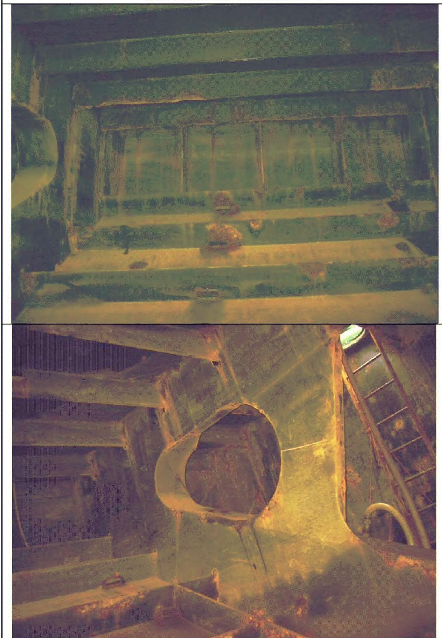
УДОВЛЕТВОРИТЕЛЬНОЕ СОСТОЯНИЕ ПОКРЫТИЯ
