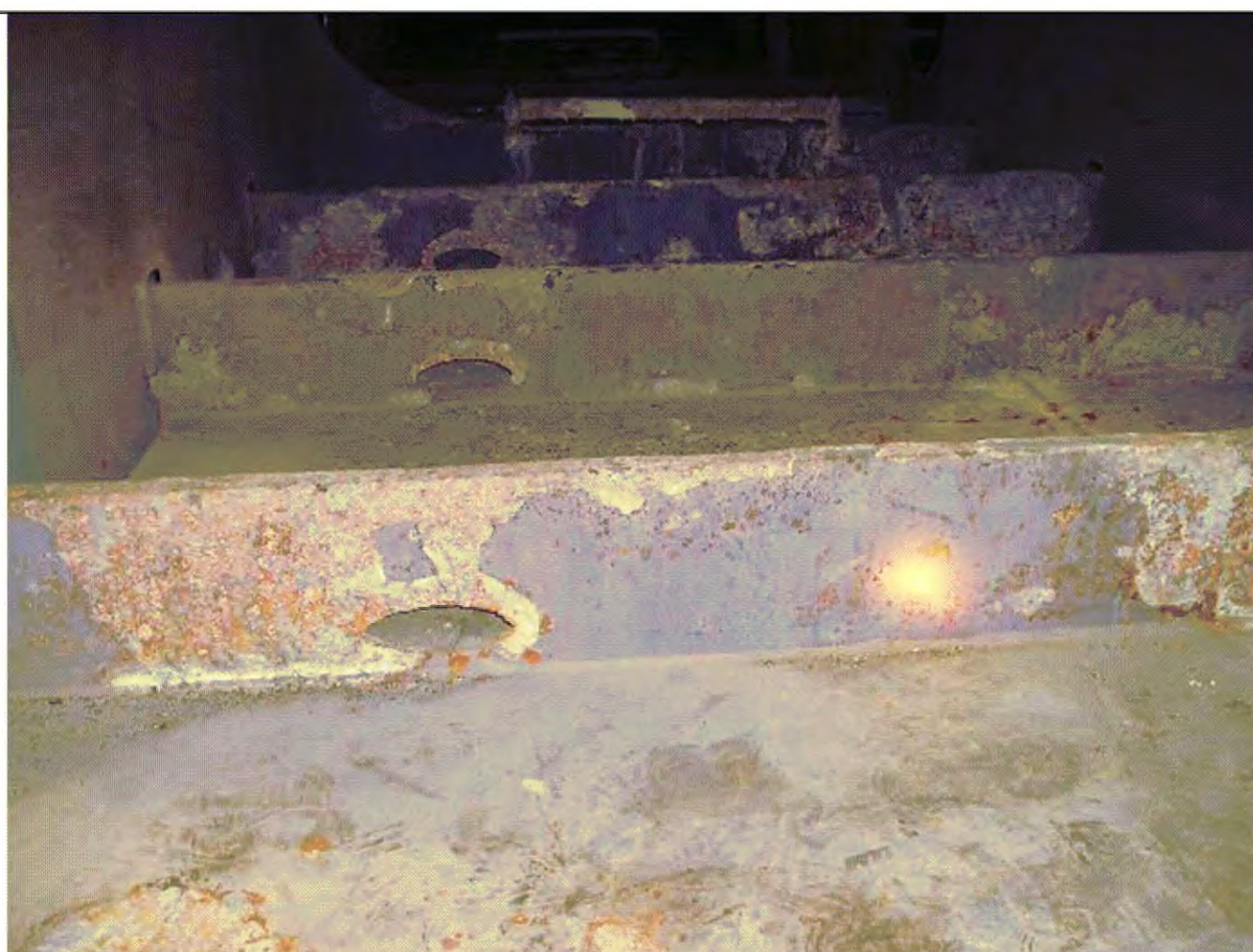
ПЕРЕХОД УДОВЛЕТВОРИТЕЛЬНОГО СОСТОЯНИЯ ПОКРЫТИЯ В ПЛОХОЕ ЭТО - ПЛОХОЕ СОСТОЯНИЕ
