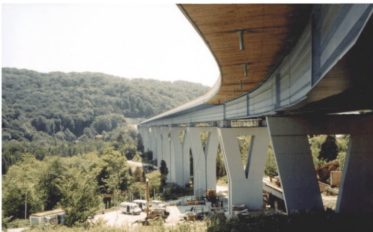
Рисунок 6.5 – Мост рамно-неразрезной системы через долину р. Мацеста в г. Сочи
