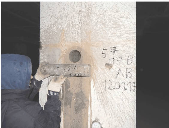
Фото 7 – Отобранная проба бетона - керн
