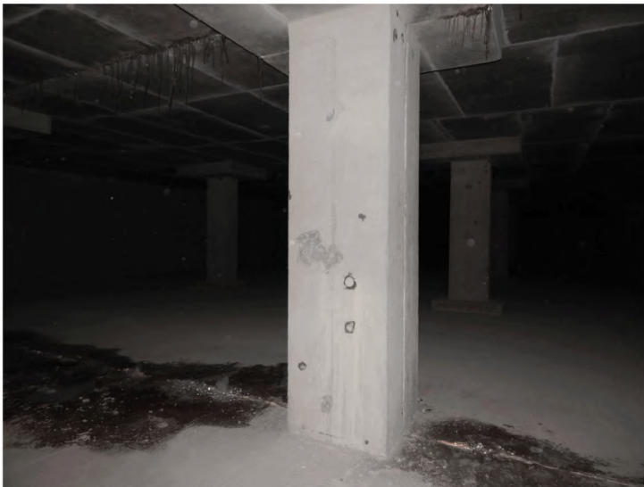
Фото 1 – Работы по отбору пробы бетона – керна из железобетонной конструкции
