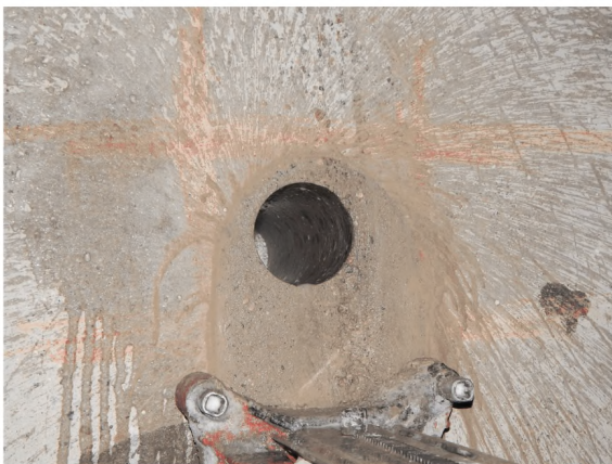
Фото 6 – Работы по отбору пробы бетона – керна из железобетонной конструкции
