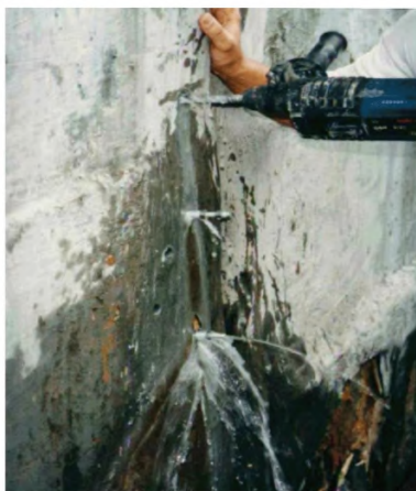
Рисунок 5 – Установка иньекторов
