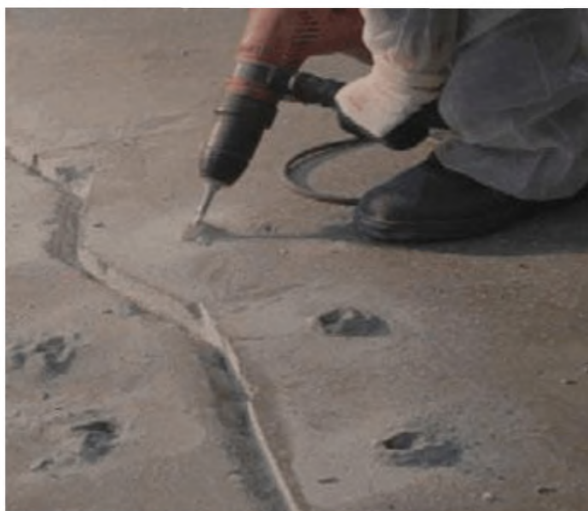
Рисунок 3 – Бурение отверстий для установки инъекторов
