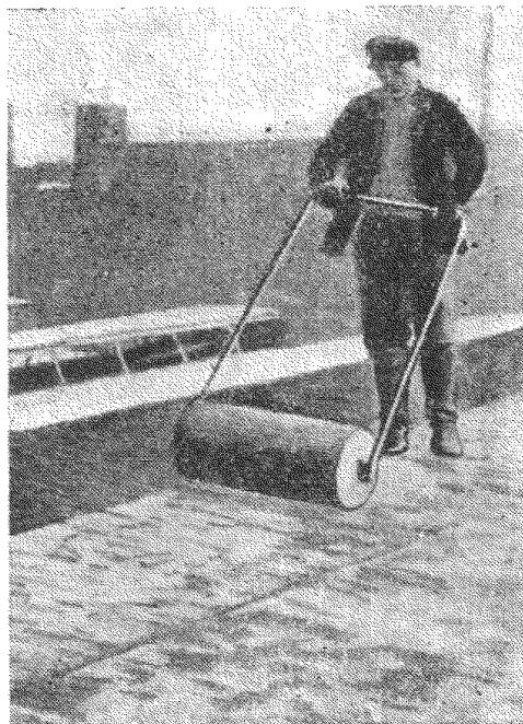
Рис. 26. Прикатка рулонного материала цилиндрическим катком
