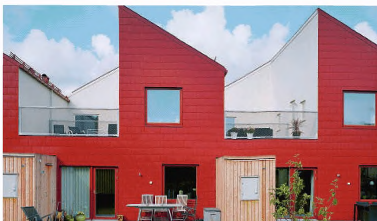
Гетеборг, Швеция © Kalle Sanner / White Architects
