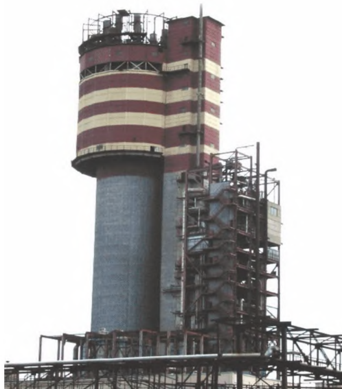
Рисунок 8.13 – Башня прилливания с железобетонным стволом
